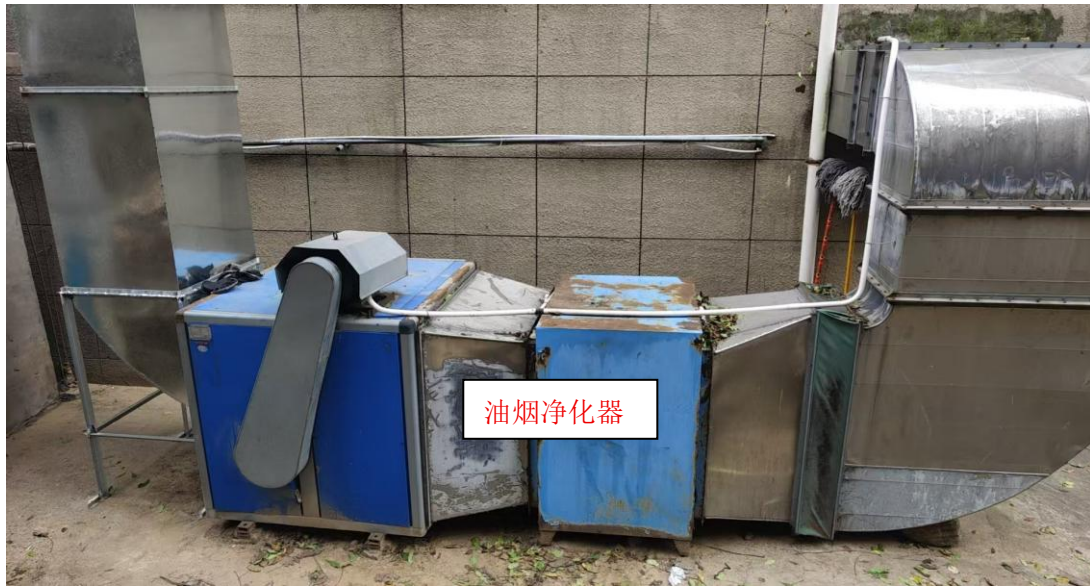
图 6.2-1 莲花宾馆餐饮油烟收集及治理措施
