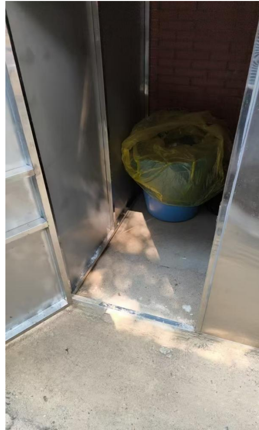
医疗废物暂存间（五星村院区）
