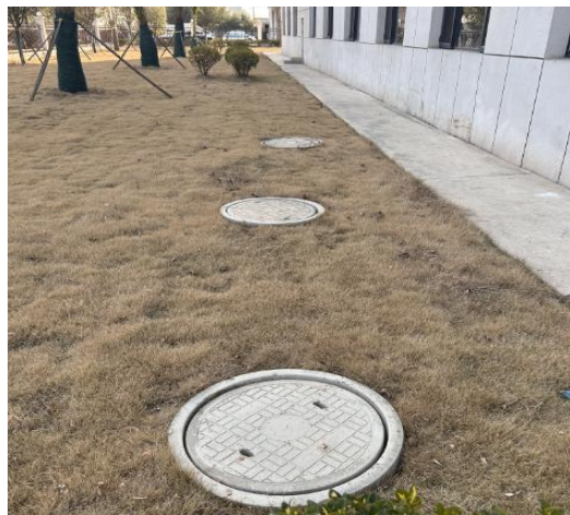
隔油池+化粪池
