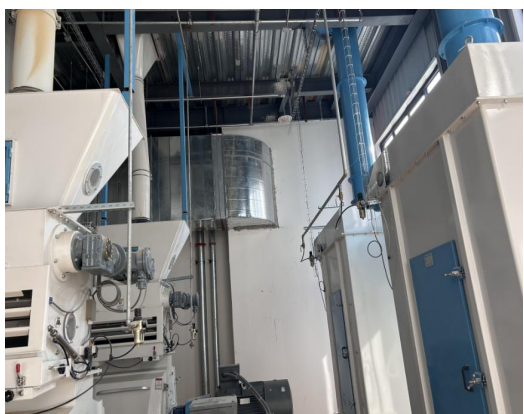
生产环节脉冲除尘器
