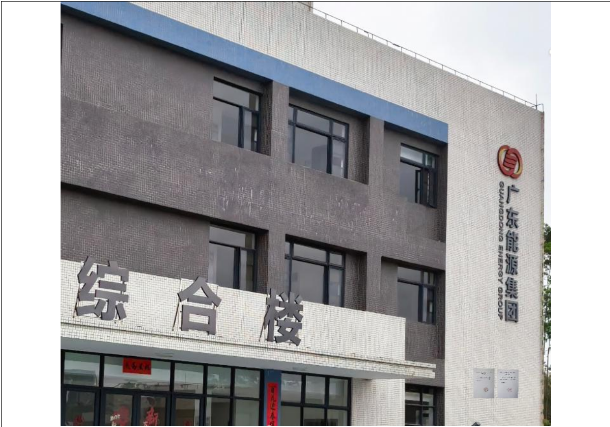
竣工、调试公示张贴
