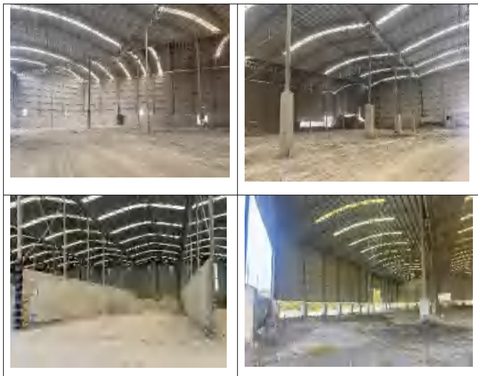
图5.1-1 项目地块内部砂石储料仓踏勘情况照片
