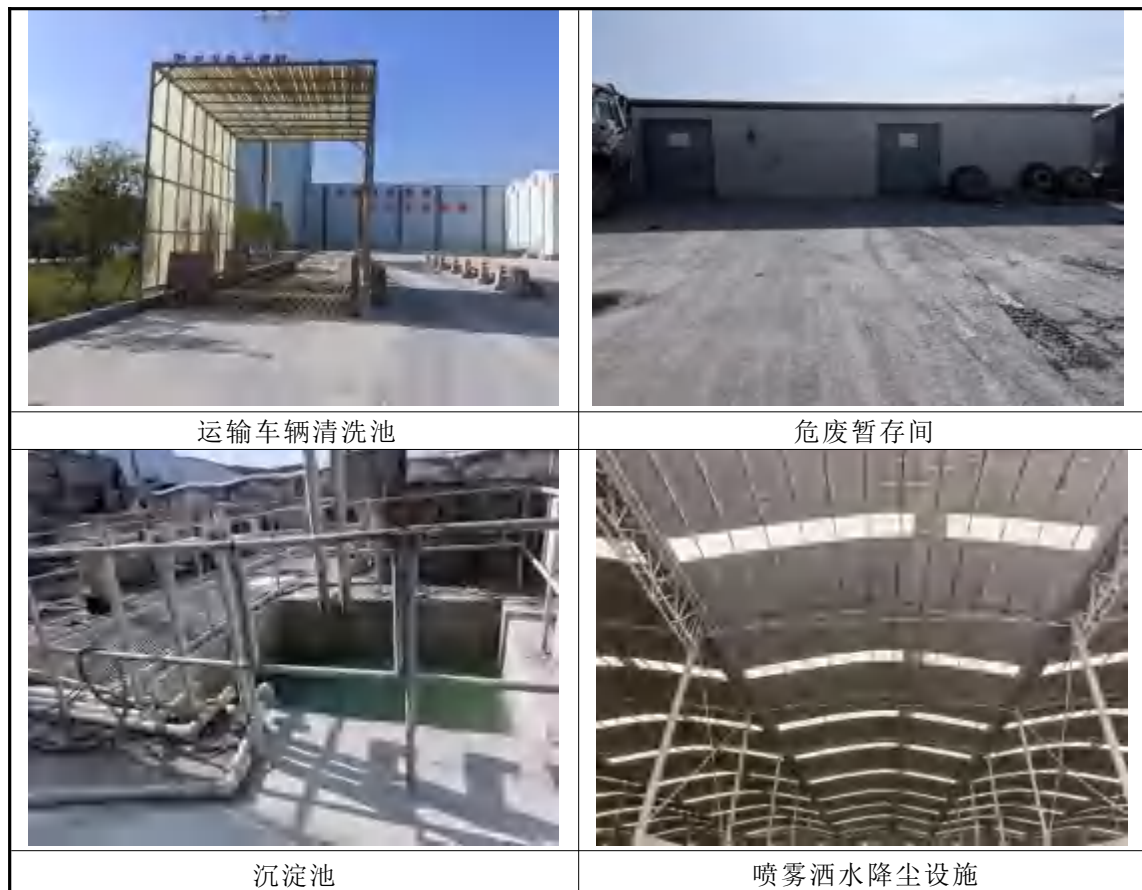
图3.4-1 建设大道-01破损山体整理与资源再利用项目“三废”处置设施照片
