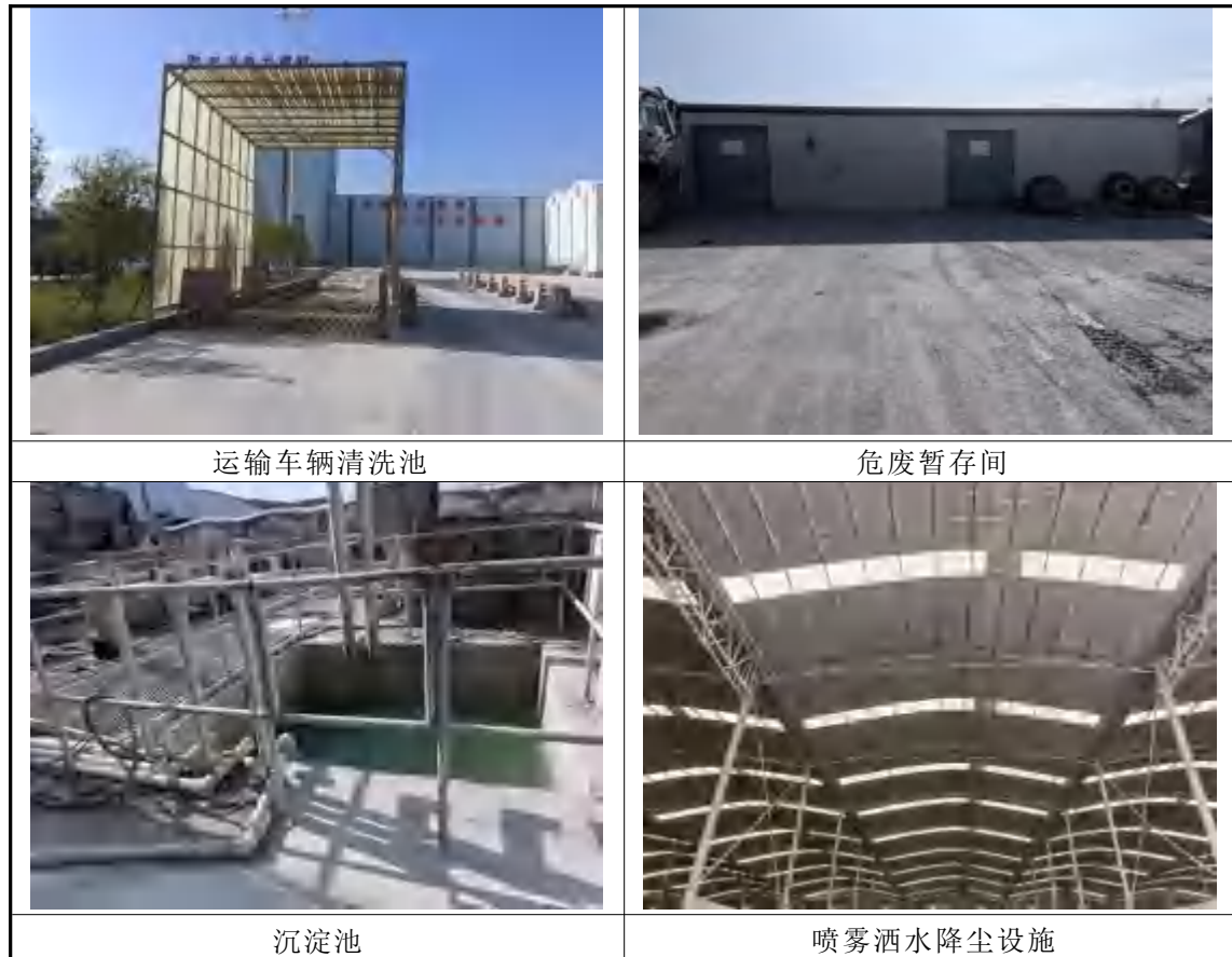
图3.4-1 建设大道-01破损山体整理与资源再利用项目“三废”处置设施照片
