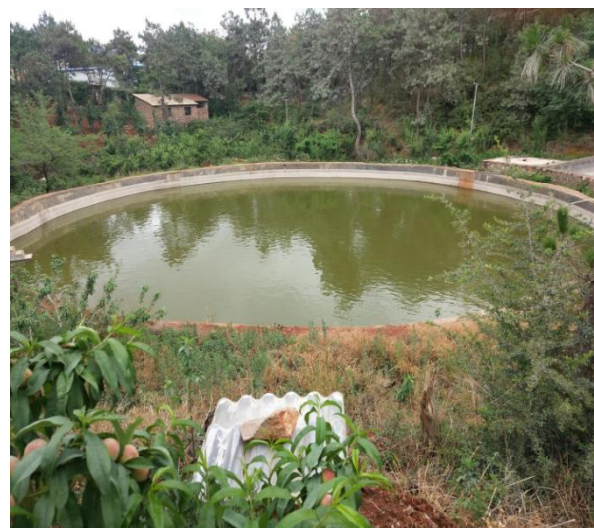
照片 16：雨水收集池
