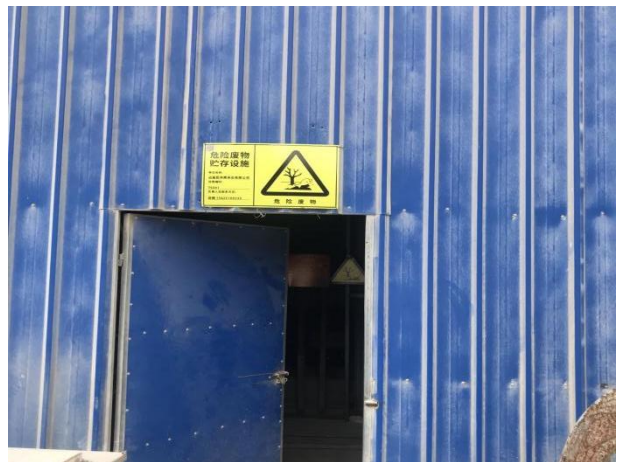
照片 6：危废暂存间 1#
