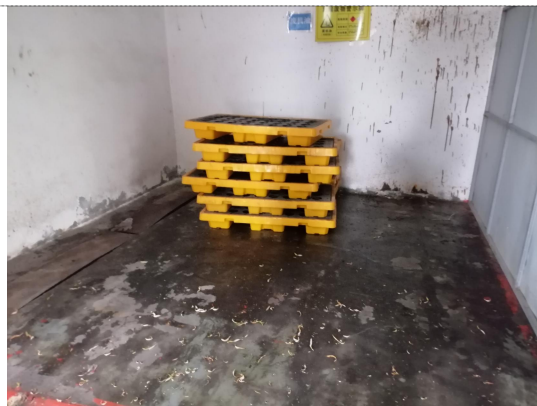
废机油贮存设施处标识
