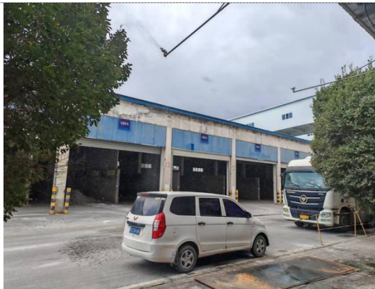
运输车辆冲洗（整改前）
