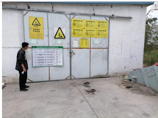
危废暂存间标识
