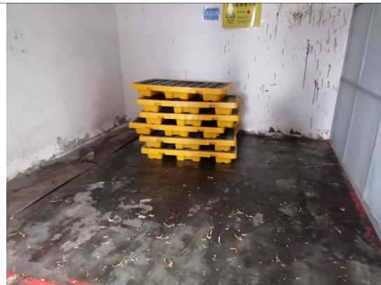
废机油暂存区及危废标识
