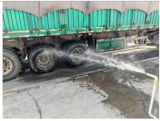
运输车辆冲洗（整改后）
