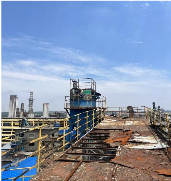
1#水泥仓布袋除尘器
