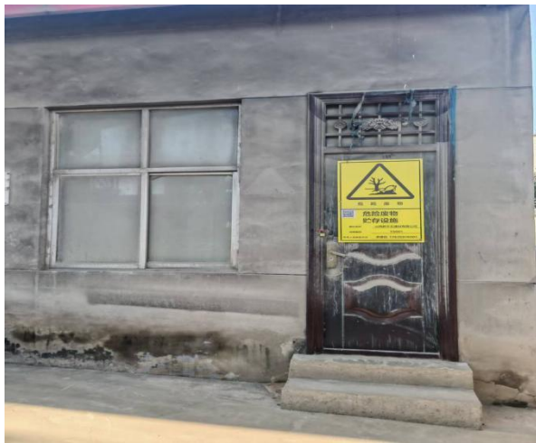
危险废物贮存间
