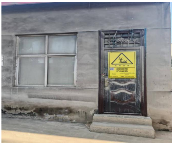
危险废物贮存间
