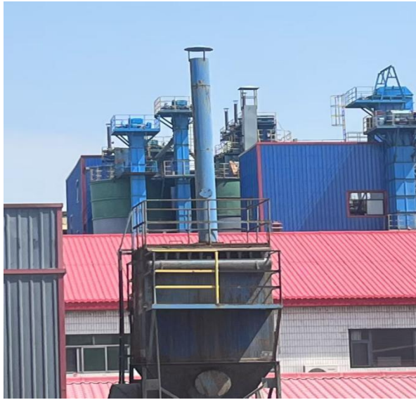
皮带转载点布袋除尘器
