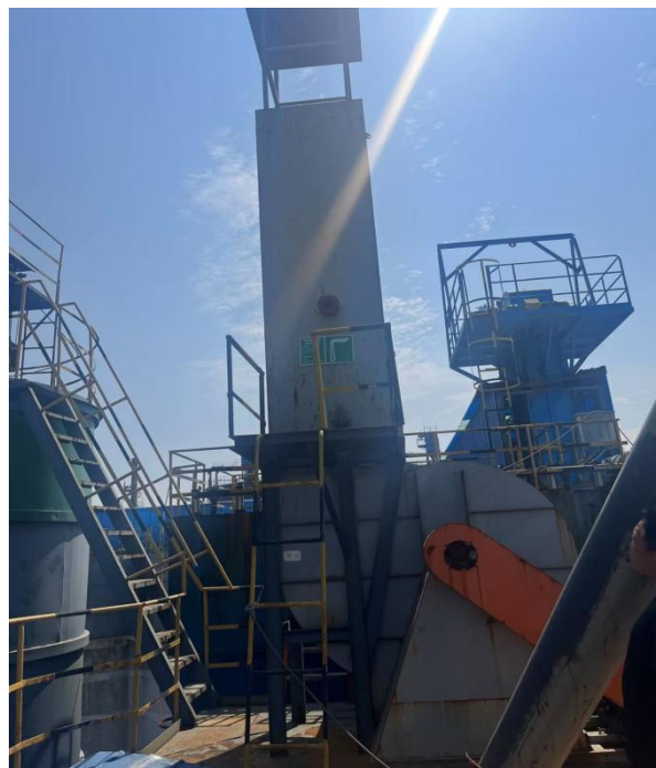
原料制砂、选粉、提升机布袋除尘器
