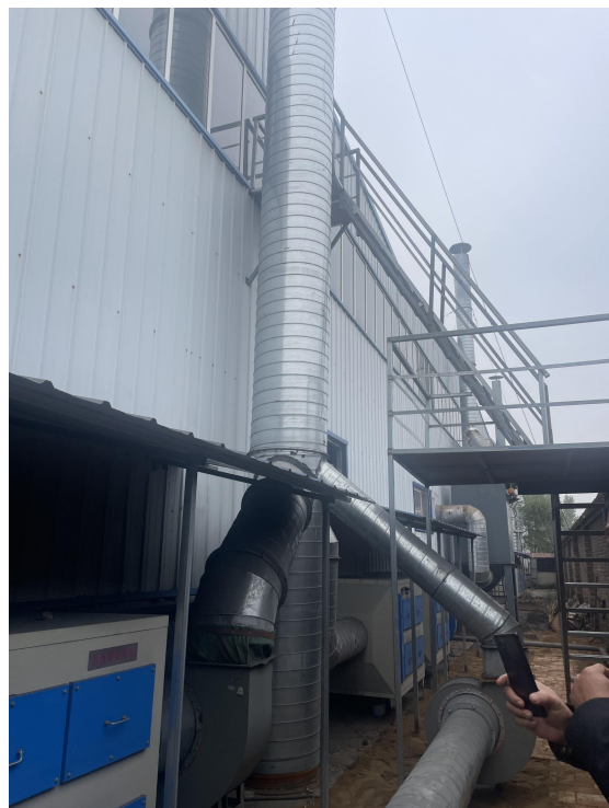
检测平台、排气筒
