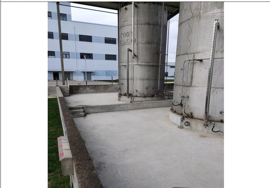
储罐区：储罐区均设置有隔水围堰，地面完好无破损。
