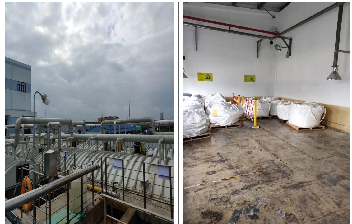
三废处理区：废水处理设施上方均已加盖，危废仓库存储的危险废物会对土壤和地下水产生污染，现场踏勘显示地面均已硬化，并有防水防渗涂层，地面完好无破损裂痕。
