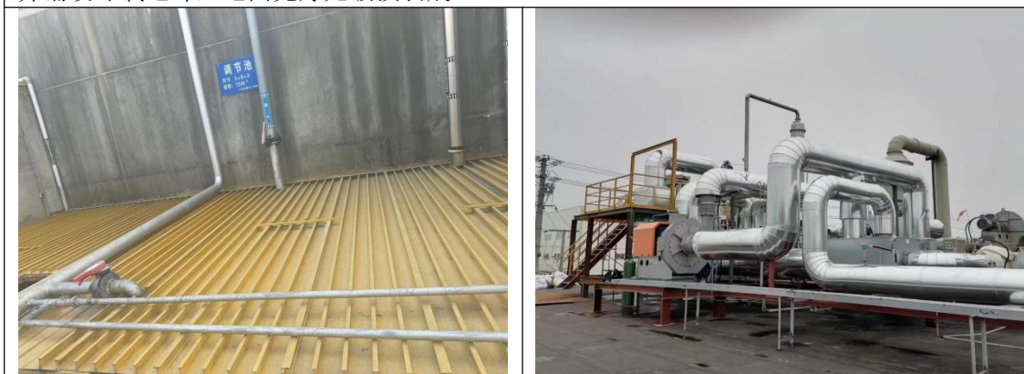
三废处理区：废水处理设施上方均已加盖，废气处理设施正常运行，地面完好无明显破损裂痕。
