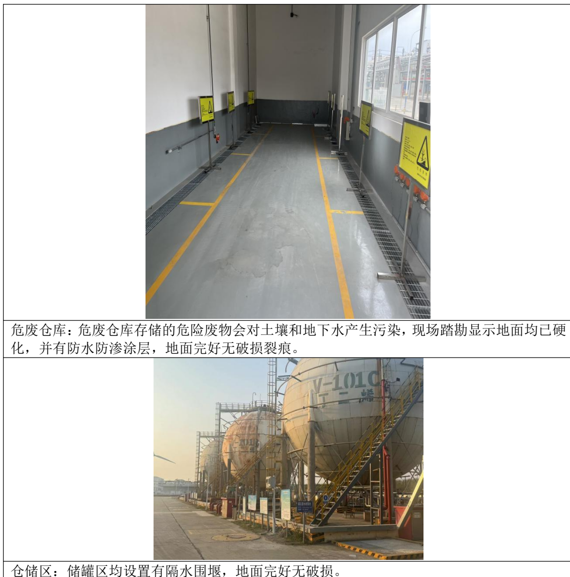
图 5.1-1 现场踏勘图片见图
