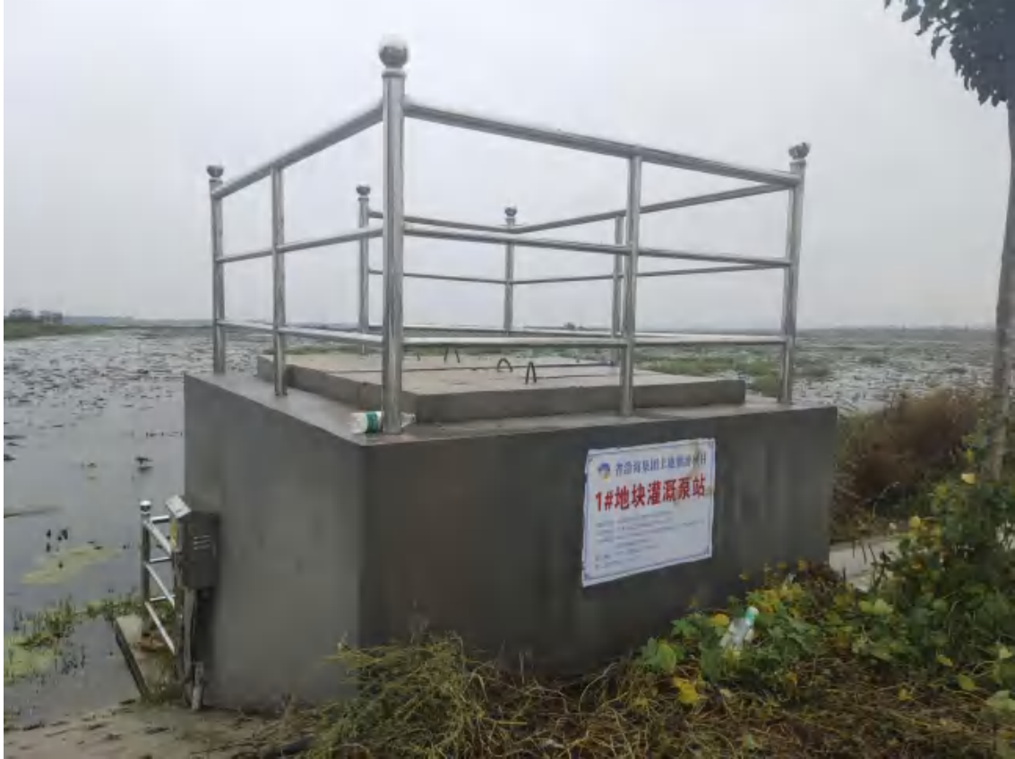
灌溉泵站建设
