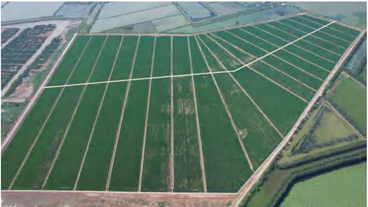
1#排泥池-1 复垦现状
