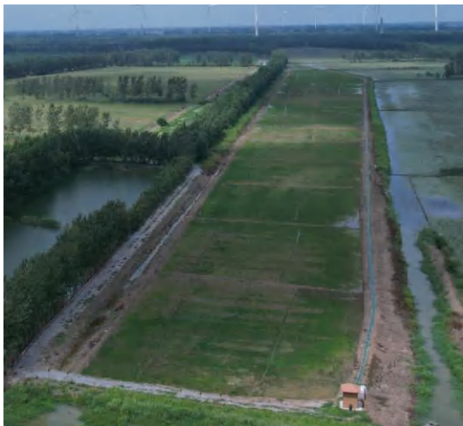
1#排泥池-3 复垦现状
