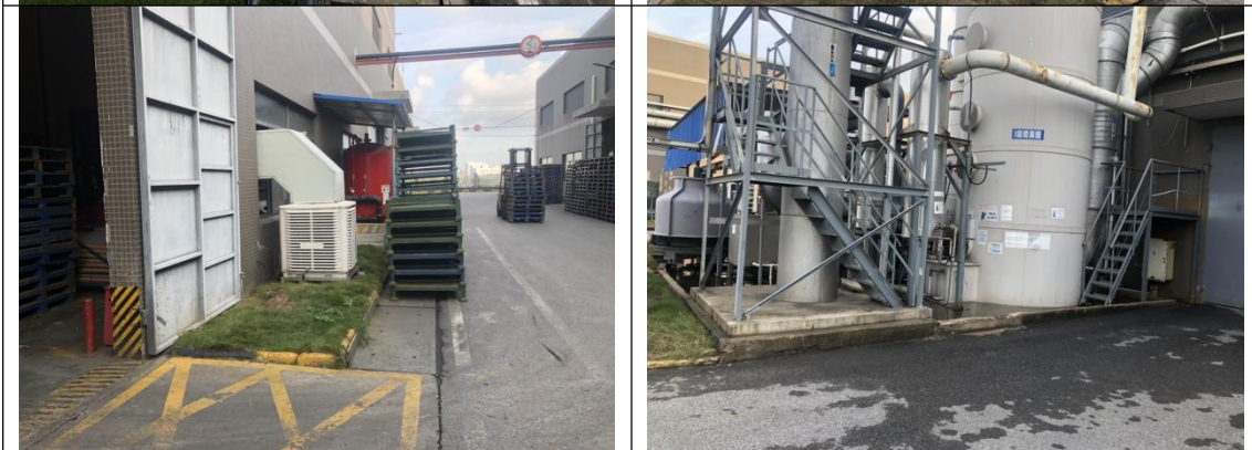
生产车间：生产过程中原辅材料可能对土壤和地下水产生污染，现场踏勘显示地面均已硬化，地面完好无破损裂痕。
