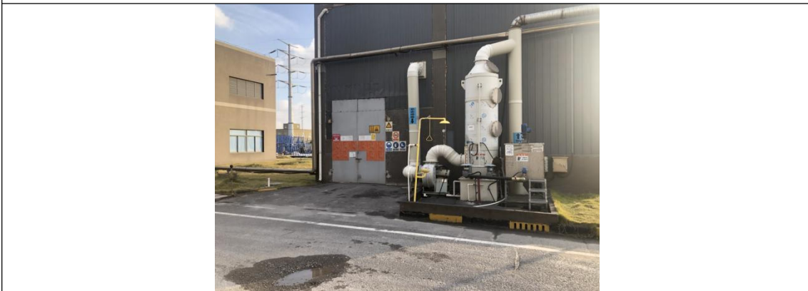
三废处理区：废水处理设施上方均已加盖，废气处理设施已设置围堰，地面完好无明显破损裂痕。
