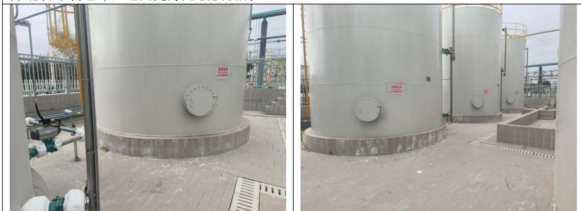
储罐区：储罐区均设置有隔水围堰，地面完好无破损。
