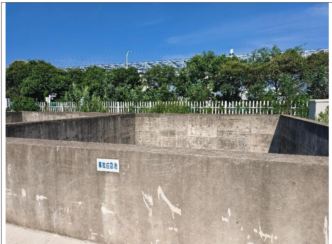
事故及消防池：事故水及消防水可能对土壤和地下水产生污染，现场踏勘显示地面及墙体均硬化，完好无损。
