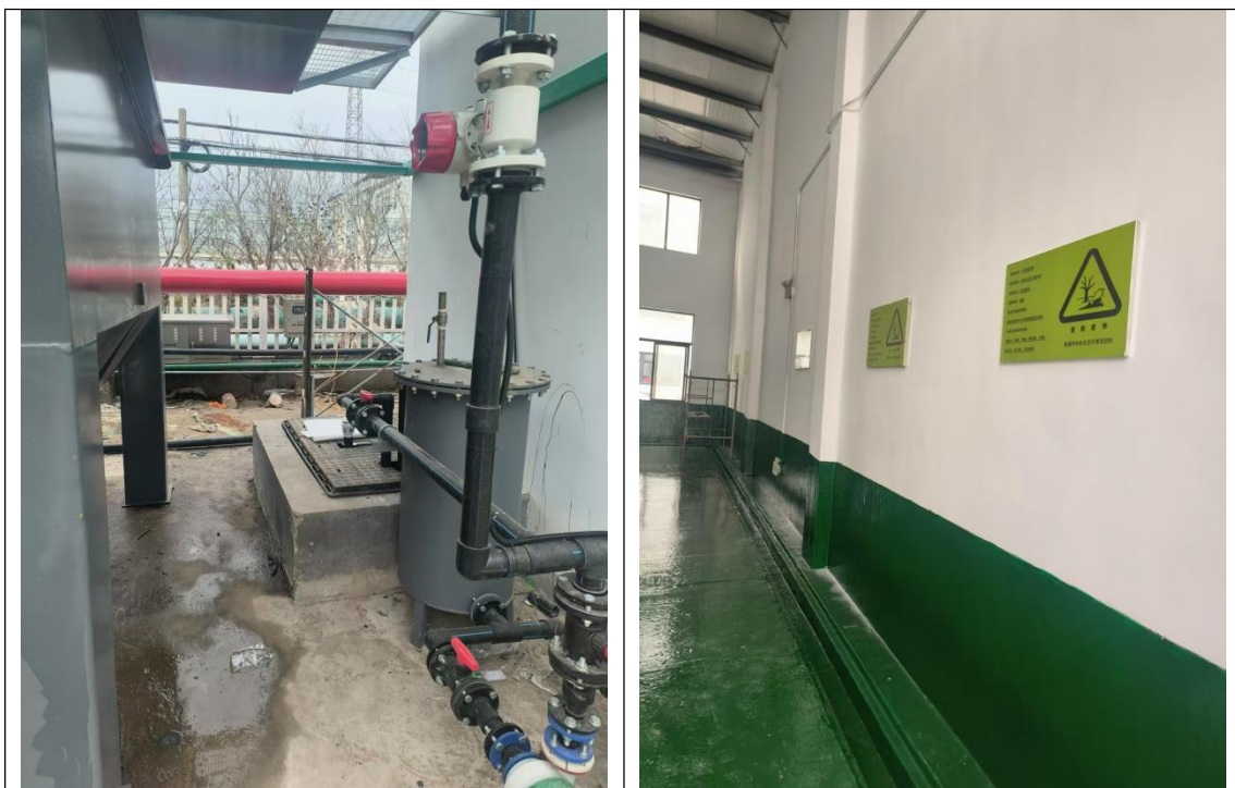
三废处置区：废水处理设施上方均已加盖，危废仓库存储的危险废物会对土壤和地下水产生污染，现场踏勘显示地面均已硬化，并有防水防渗涂层，地面完好无破损裂痕。
