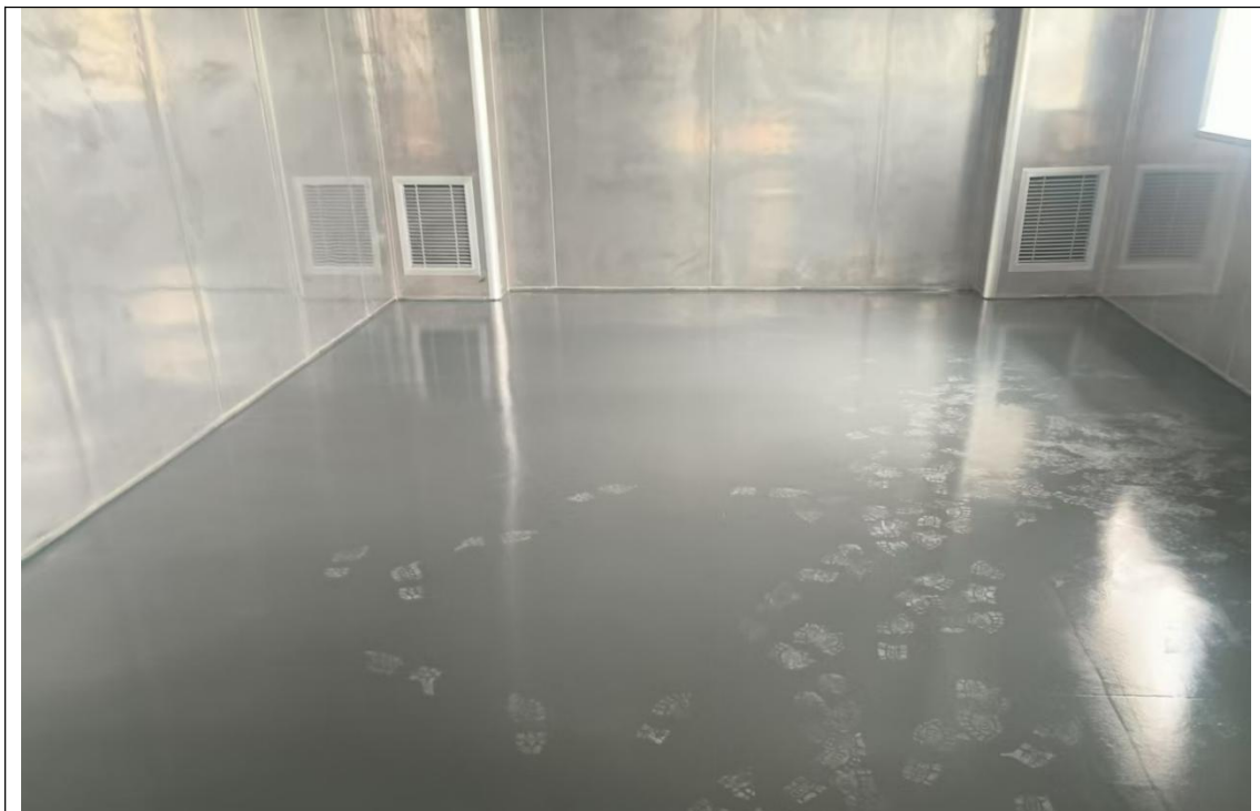
生产区：生产过程中原辅材料可能对土壤和地下水产生污染，现场踏勘显示地面均已硬化，并铺设环氧地坪，地面完好无破损裂痕。
