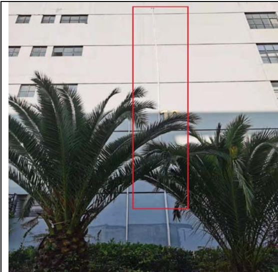
清洗废水接隔油池管
