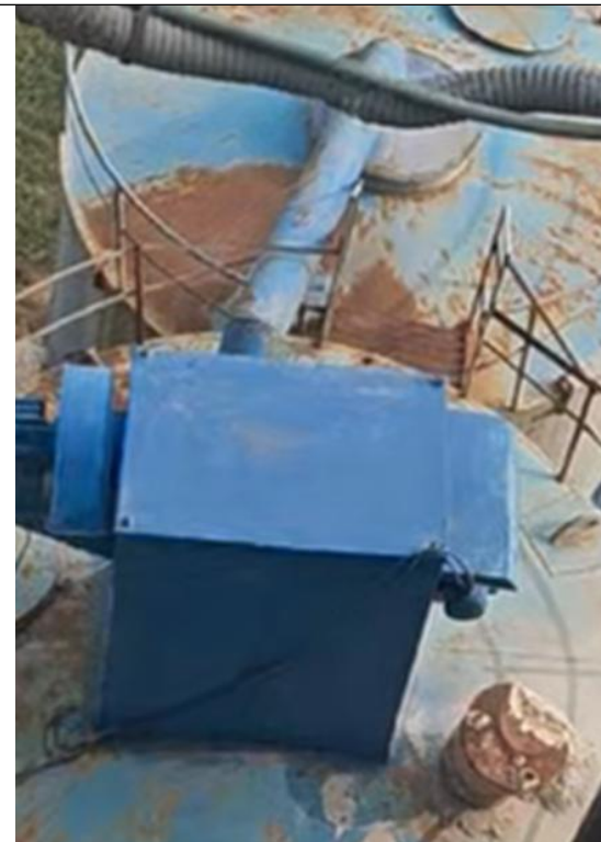
3#、4#储仓罐袋式除尘器 (TA003)
