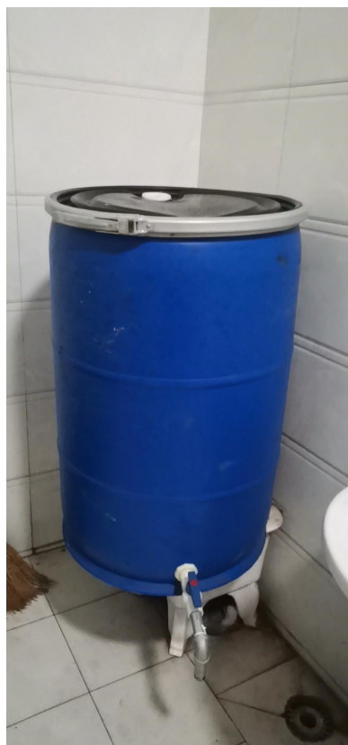
图3-1 实验室废水中和桶 放口
