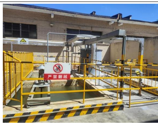
烟囱脱硫系统循环水池
