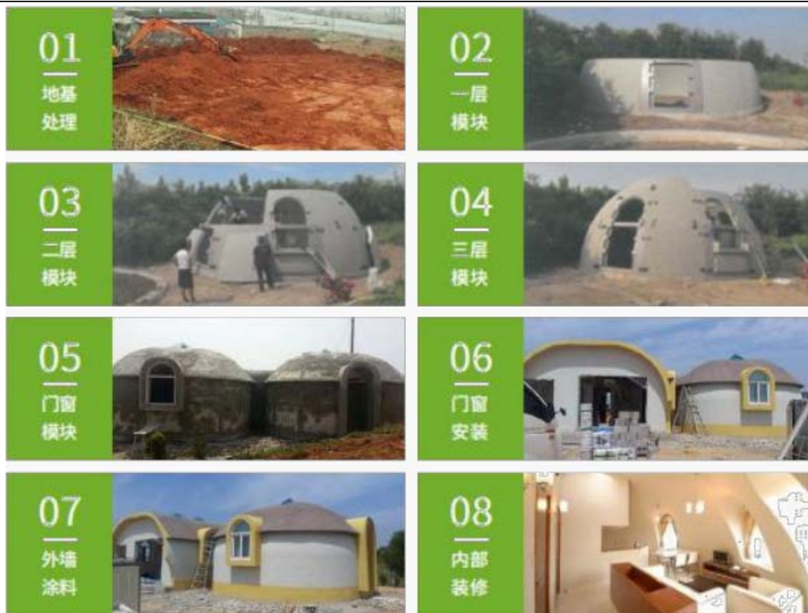
图 5-7 EPS 模块安装顺序
