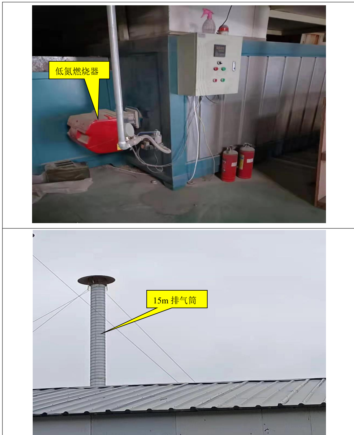
图 4-1 项目废气环保设施图
