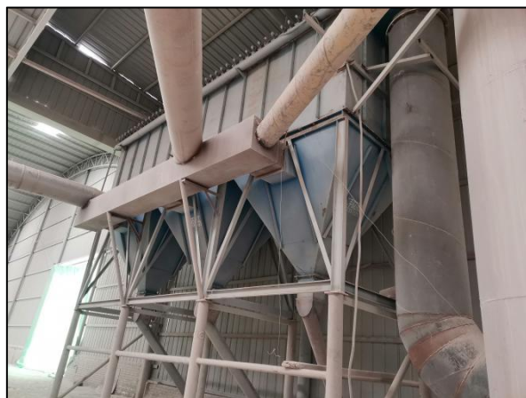
二次破碎筛分单元布袋除尘器
