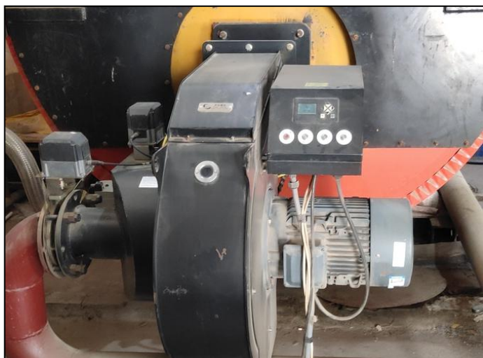
锅炉低氮燃烧装置
