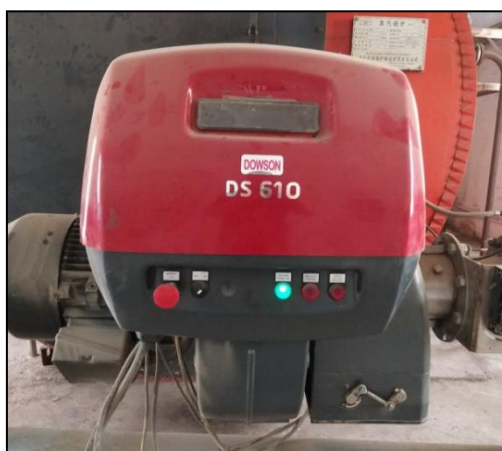
锅炉低氮燃烧装置
