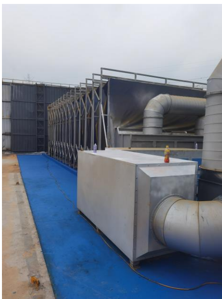
集气罩收集+脉冲布袋除尘器+15m 高排气筒
