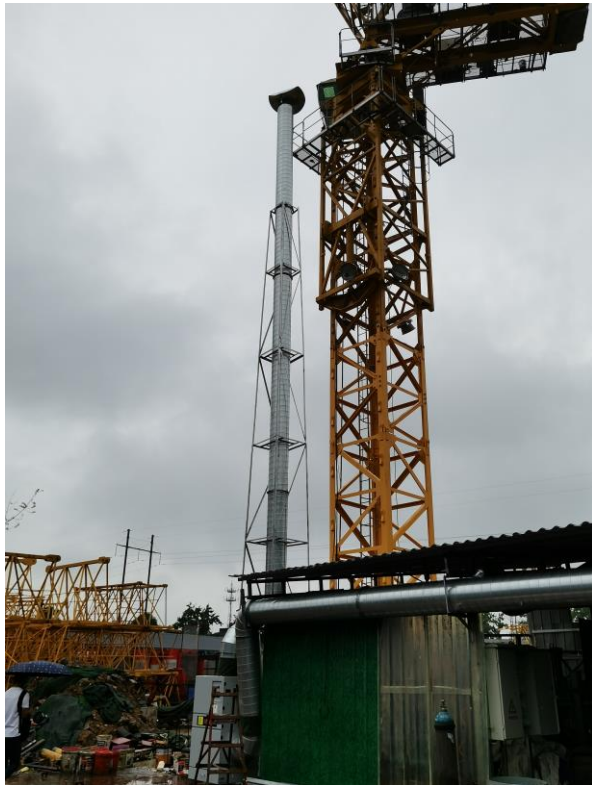
集气罩收集+脉冲布袋除尘器+15m 高排气筒
