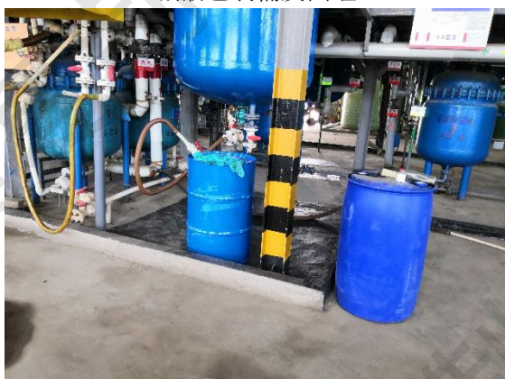
生产装置区围堰
