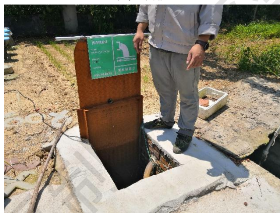
雨水外排口及切断装置
