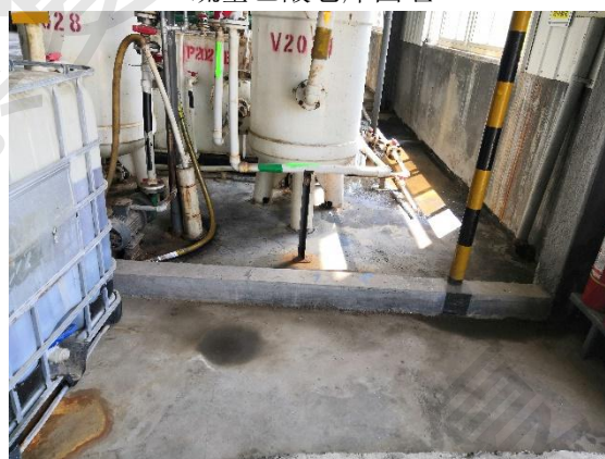
生产装置区围堰
