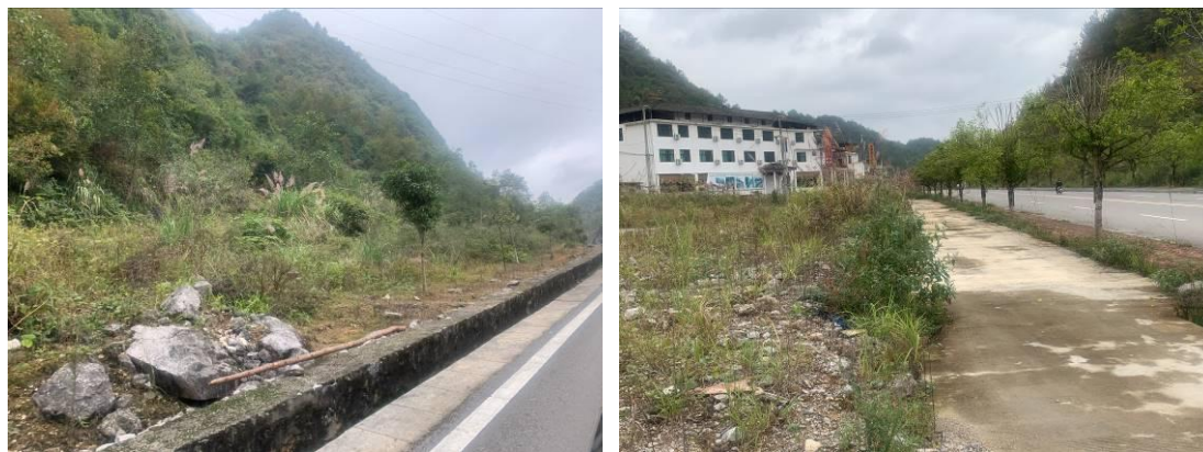
图 5.3-2 施工便道恢复情况
