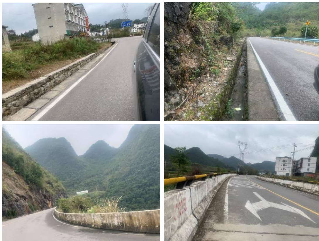
图 7.2-1 本项目桥梁防撞护栏以及路面排水沟现状情况
