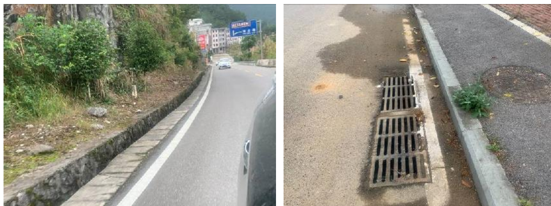
图 5.3-4 本公路排水边沟建设情况图
