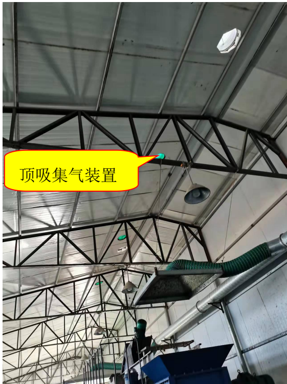
车间房顶顶吸集气装置
