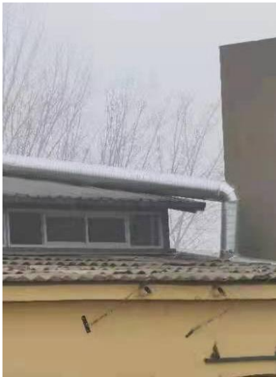
车间房顶顶吸集气管路
