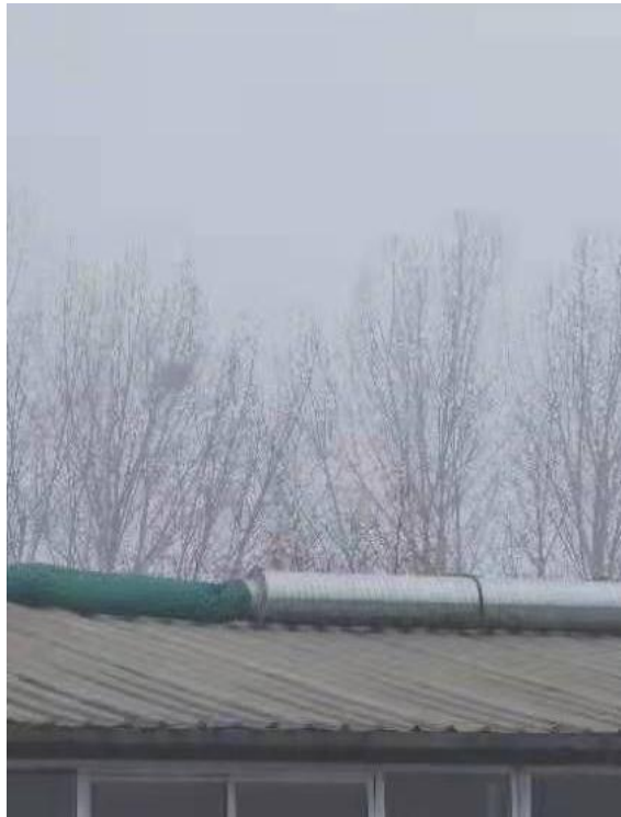
车间房顶顶吸集气管路
