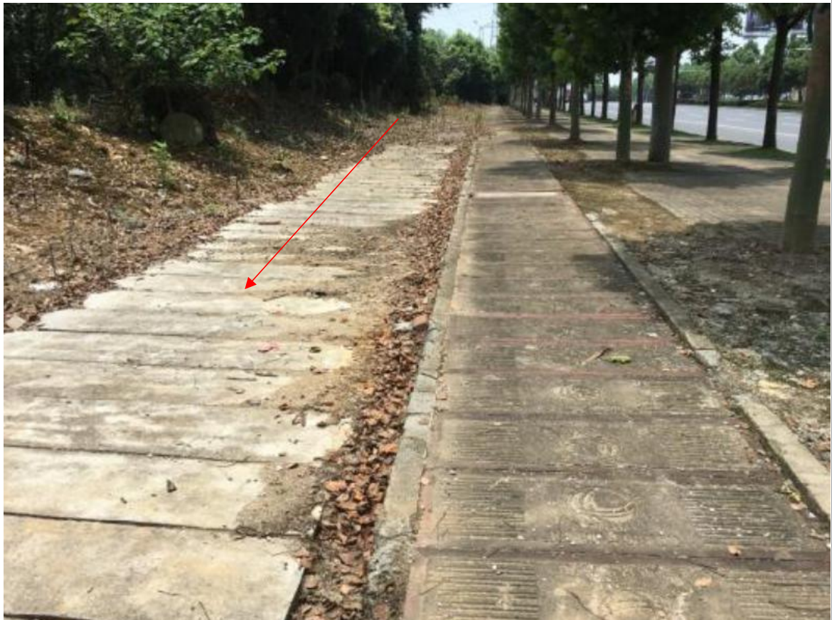
图 2-7 长江大道东侧的电缆沟廊道
