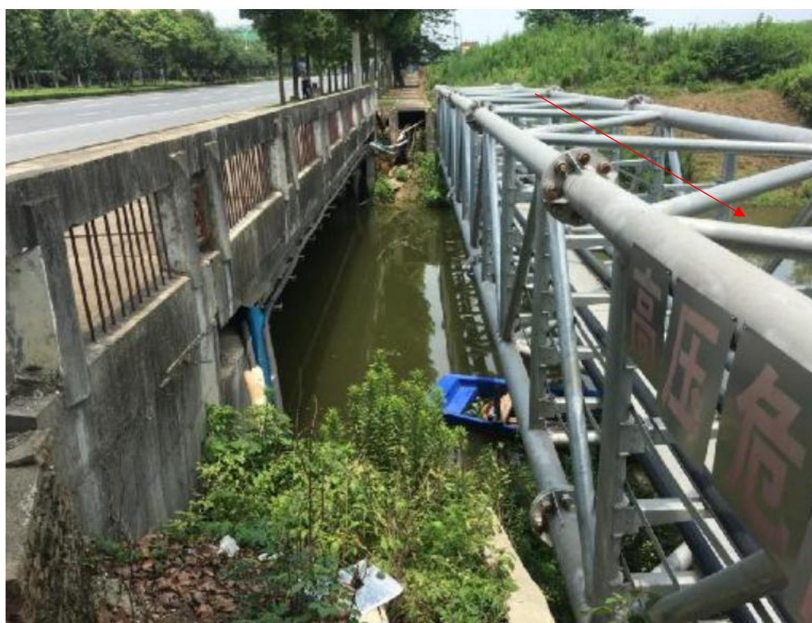
图 2-5 采用桥架过河（Ⅲ类水质）
