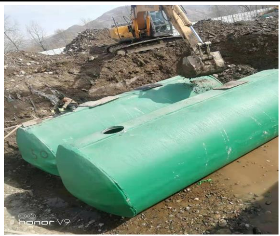
化粪池施工照片
