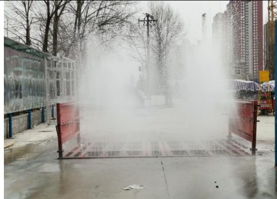
施工期车辆冲洗平台
