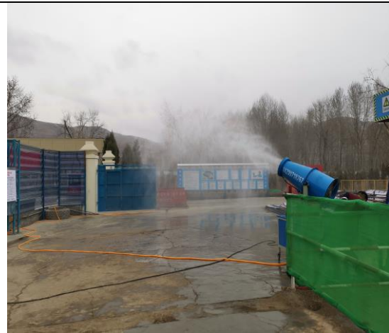
施工期降尘措施
