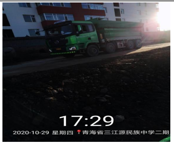
施工期密闭运输
