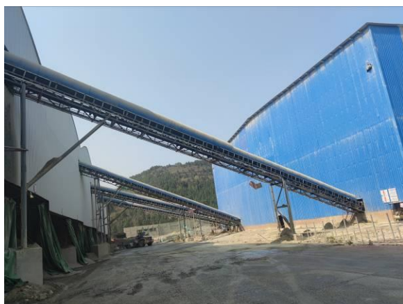
图 3-3 成品输送皮带
