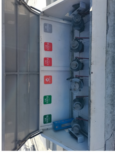
卸油口一次油气回收装置
