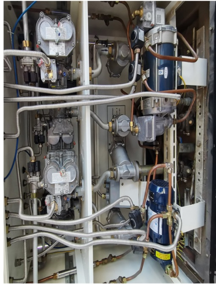
加油机二次油气回收装置
