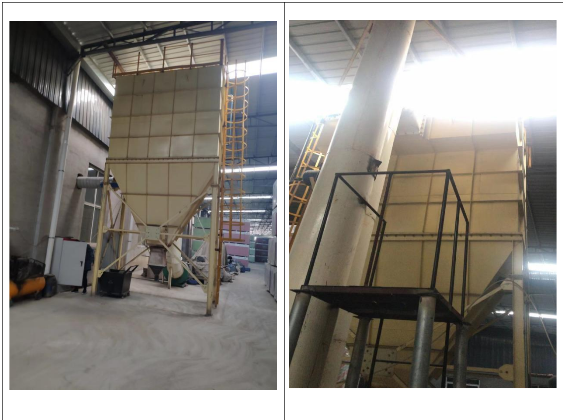
图 5 布袋除尘器+15m 高排气筒
