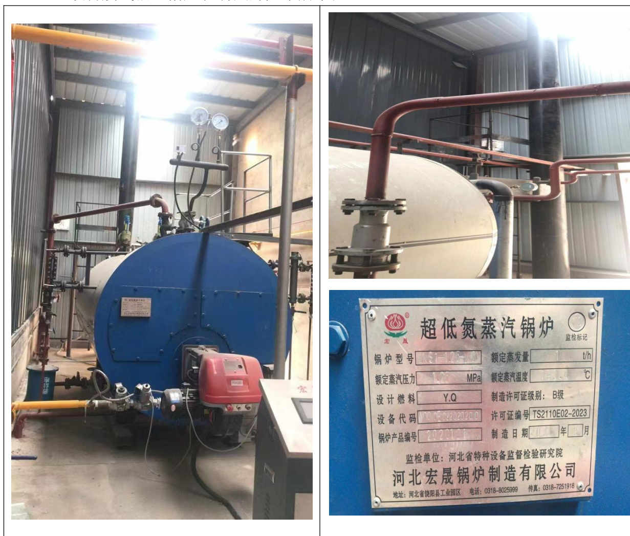
图 4 锅炉低氮燃烧器+8m 高排气筒
